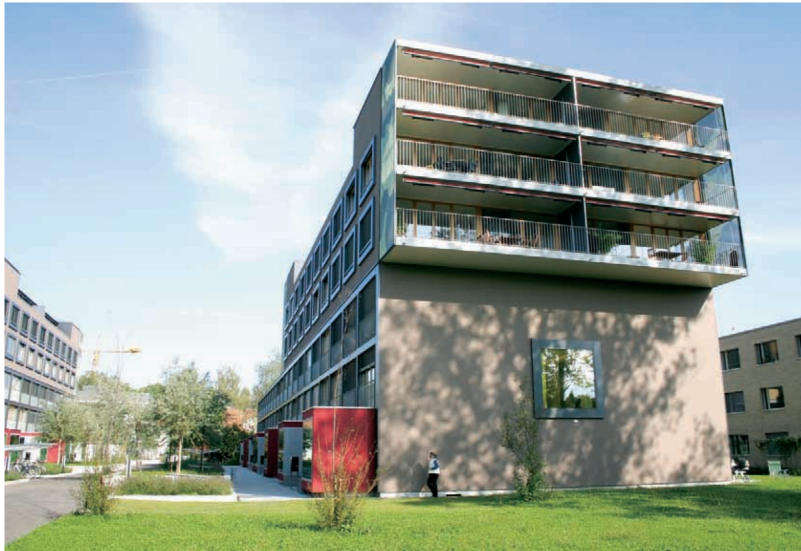
Wegweisende Architektur am Eulachpark in Oberwinterthur: Die Wohnüberbauung mit 16 Wohnungstypen von Burkhalter Sumi Architekten.
